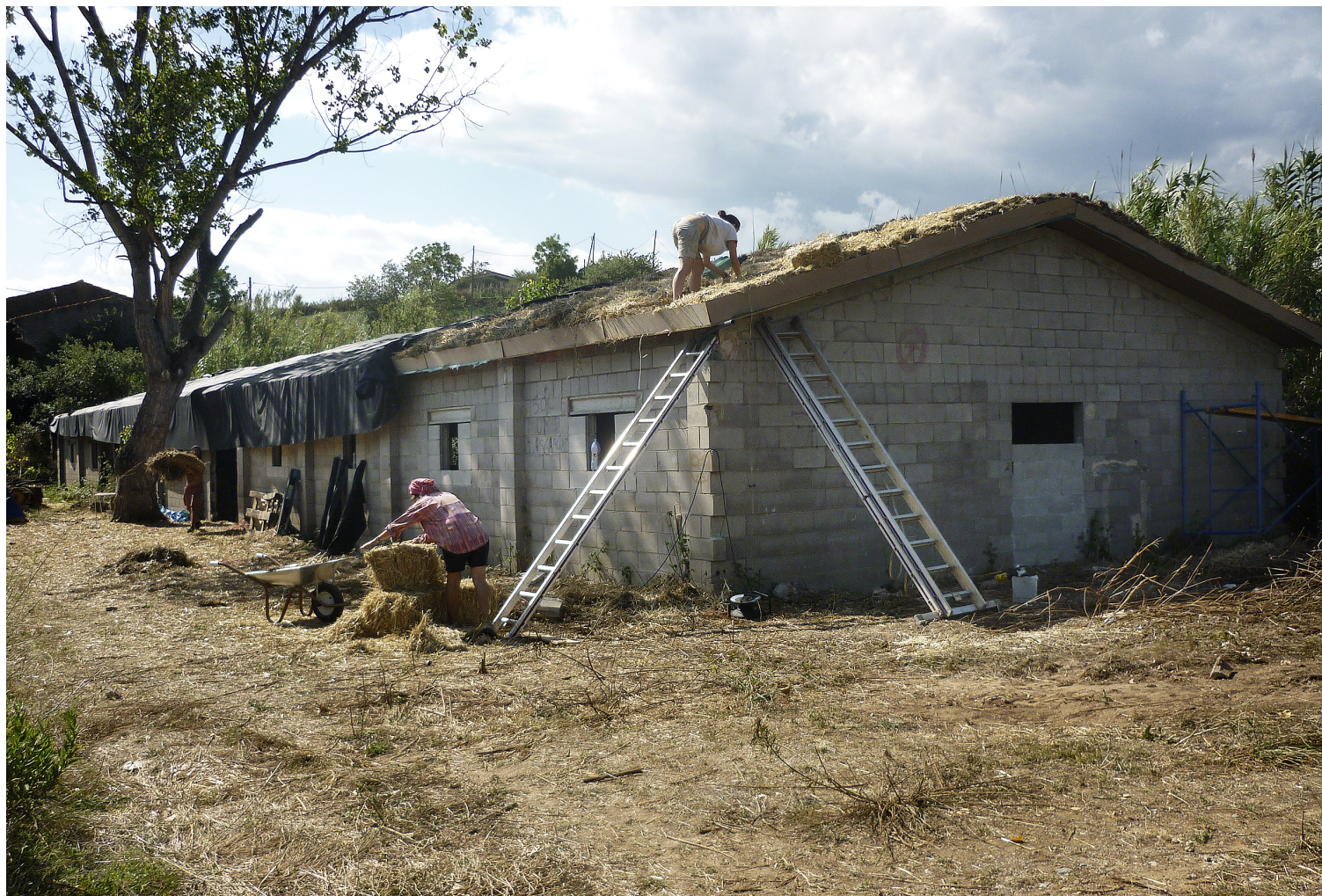
Treballs d'aïllament i condicionament de Can Tonal
